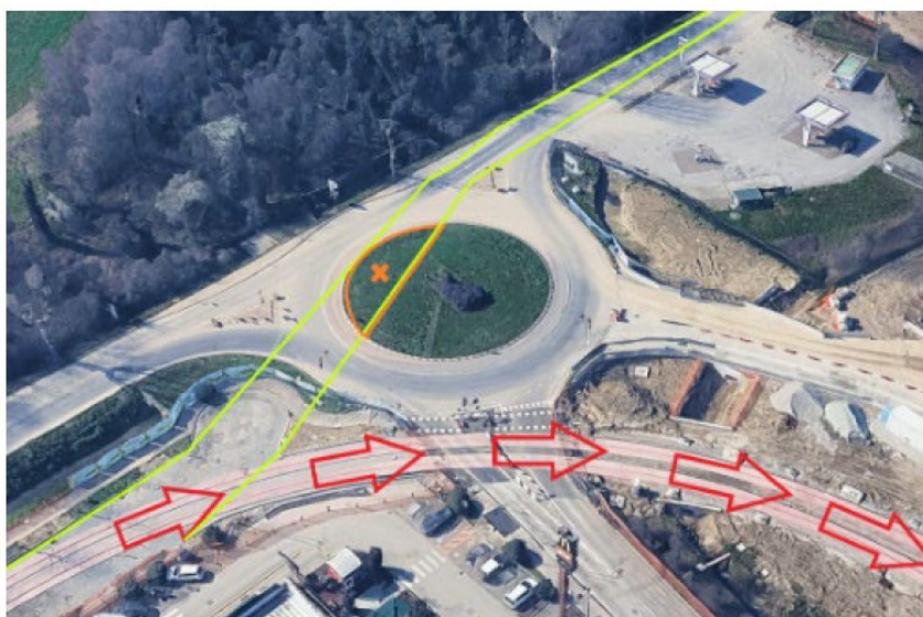
Fase 2- Transito in retromarcia verso l'interno del nuovo capolinea
